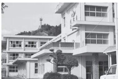
【東海中Ⅱ・Ⅲ棟校舎】
